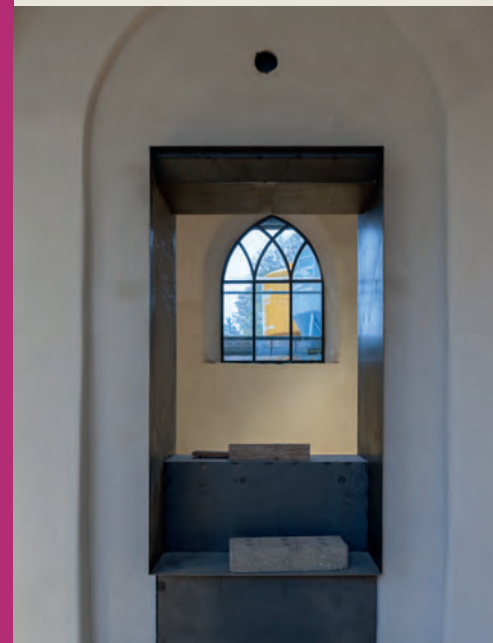
27.1 | LANDSHUTmuseum, Bauabschnitt I kurz vor Fertigstellung, November 2016, Kreuzgang, Durchblick
