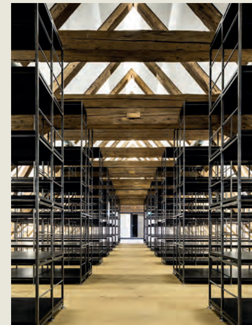
27.2 | LANDSHUTmuseum, Bauabschnitt I kurz vor Fertigstellung, November 2016, Dachgeschoss, Zentrum für Regionalkultur
