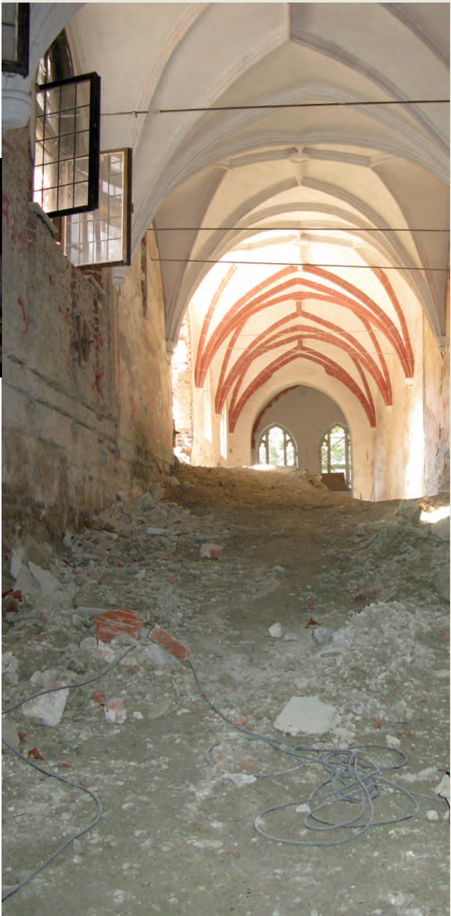
31.1 | LANDSHUTmuseum, 1. Bauabschnitt, Anpassung Bodenniveau, östlicher Kreuzgangflügel, 2015
