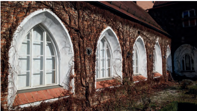
30.1 | LANDSHUTmuseum, Innenhof des Kreuzgangs zu Baubeginn, 2015
